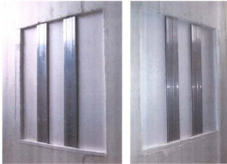
Fig. 2. I profili inseriti nel pannello di supporto. Vista esterna (a sx) vista interna (a dx)
